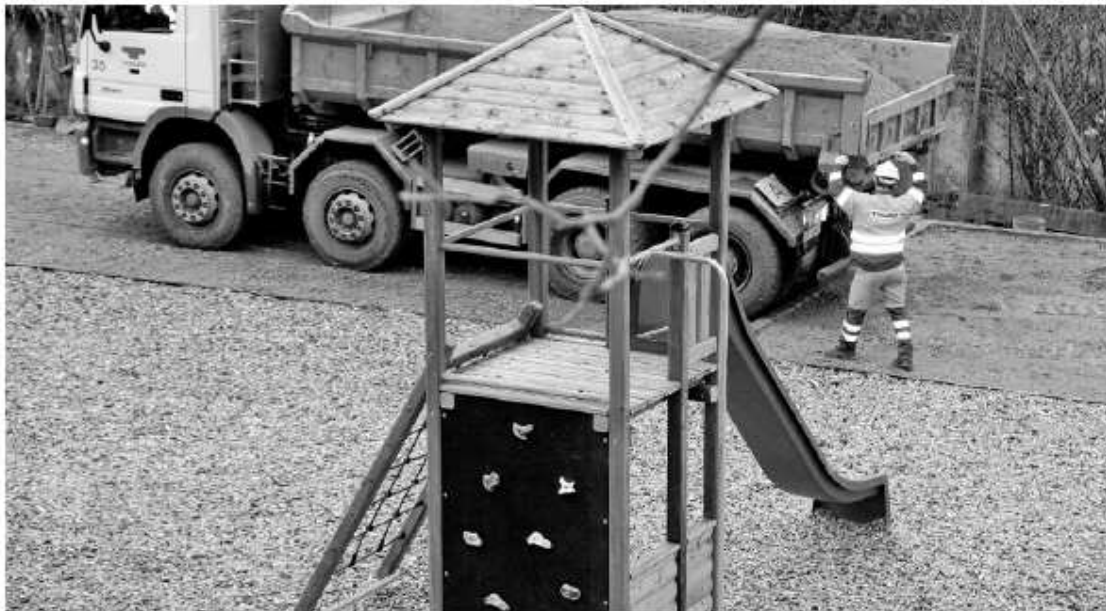
Beim Bau des neuen Spielplatzes in Wintersingen führen die Lehrlinge das Zepter.
