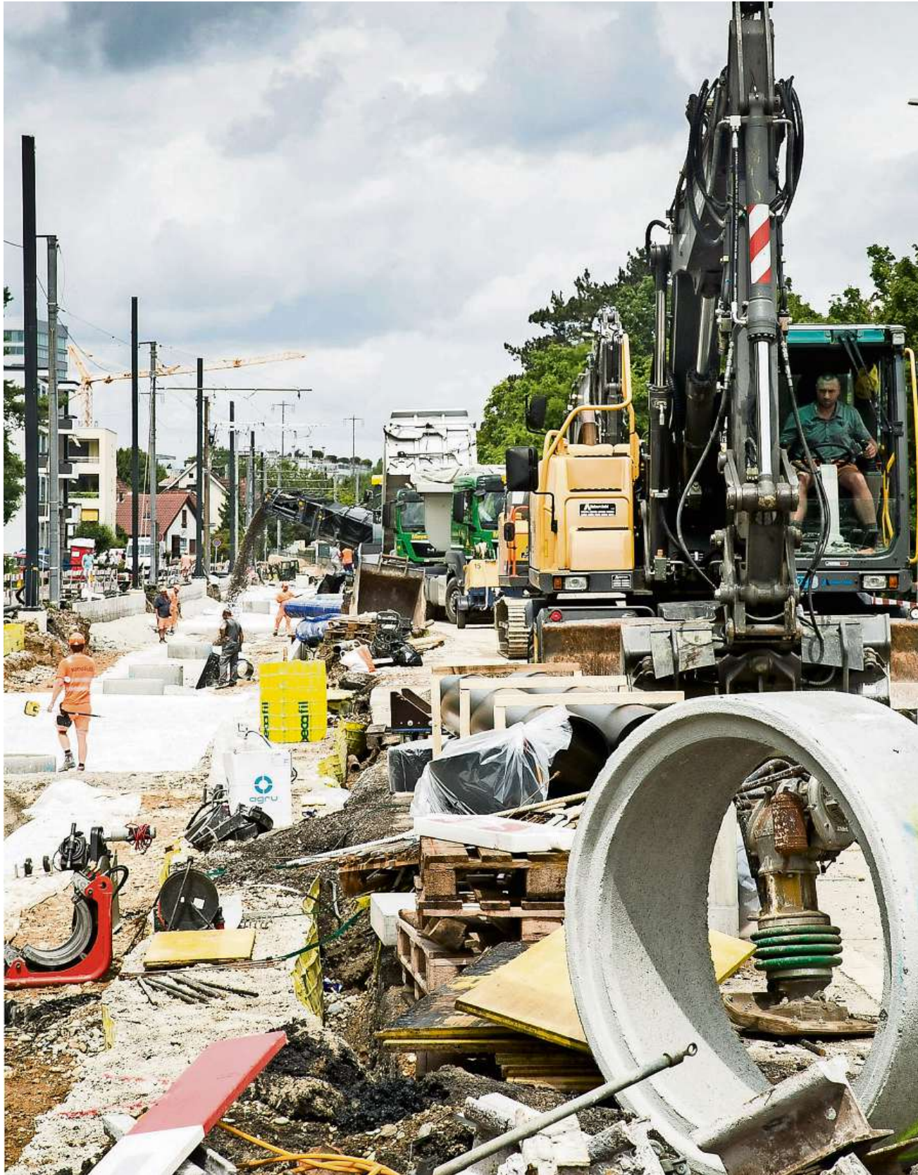
Ein Graben bis zum Horizont. An der Baslerstrasse in Münchenstein reihet sich Bagger an Bagger und Lastwagen an Lastwagen. Sechs verschiedene Baufirmen sind an den Tiefbauarbeiten beteiligt.
