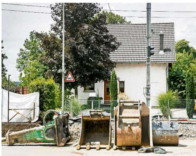
Leben im Ausnahmezustand. Die Anwohner müssen zu den Tram-Immissionen auch Baulärm ertragen.
