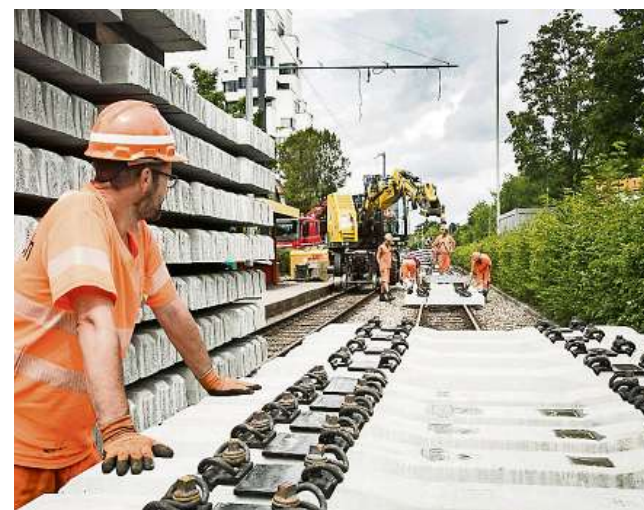
Grossflächig Gleisanlagen erneuern. Bis zu 52 Jahre alte Streckenabschnitte werden im Ober- und Unterbau ersetzt.
